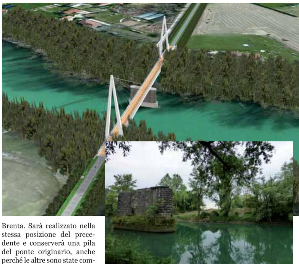
Brenta. Sarà realizzato nella stessa posizione del precedente e conserverà una pila del ponte originario, anche perché le altre sono state completamente distrutte.
