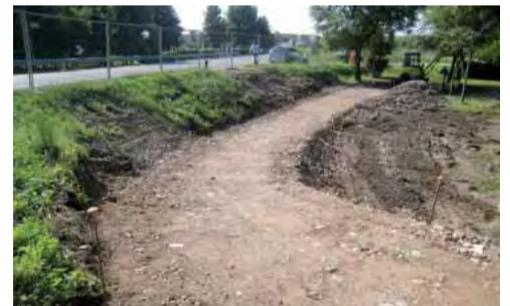
Sono stati eseguiti i lavori di realizzazione della rampa di raccordo con la pista ciclabile con materiale arido; realizzati gli scavi di sbancamento, la posa del tessuto e la stesa del materiale arido, per la formazione dei percorsi pedonali. Sono in corso di realizzazione i lavori di posa delle tubazioni e pozzetti preventivi alla posa della fontana.
